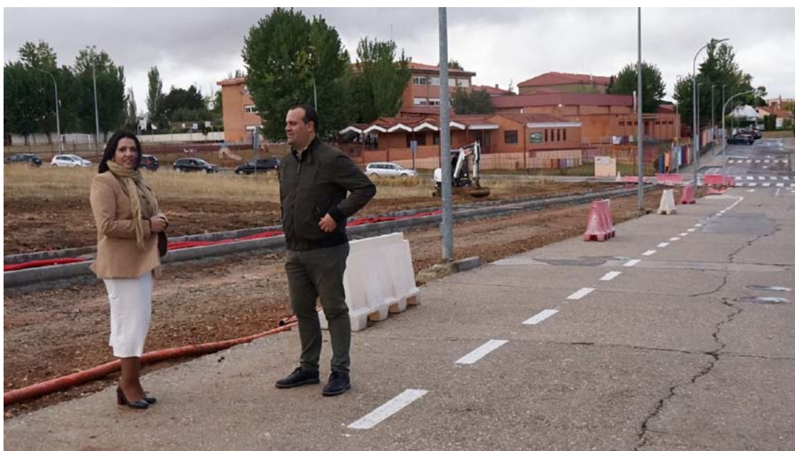
David Mingo y Silvia González en las obras para la creación de plazas de aparcamiento en la calle El Greco de Santa Marta de Tormes. Foto Ayto. Santa Marta
