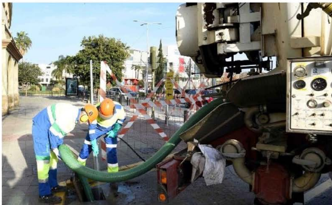
Trabajos en la zona. / FOTO: AAM
